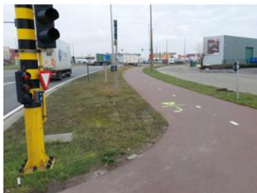
F12: aanleg verbinding in havengebied (2024)
